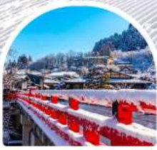
สะพานนากะบาชิ
