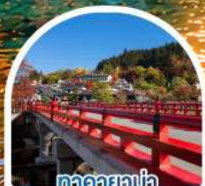
ทิวคาวาฟุจิ สะพานนากะบาชิ
