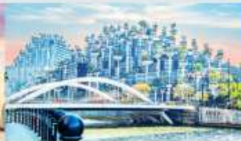
อาคารฟันทันไม้
