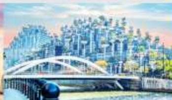
อาคารฟันทันไม
